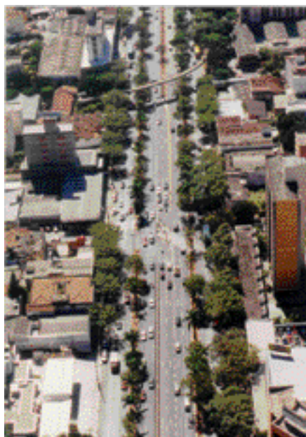
Vista aérea da Av. N. S. do Carmo, em BH
