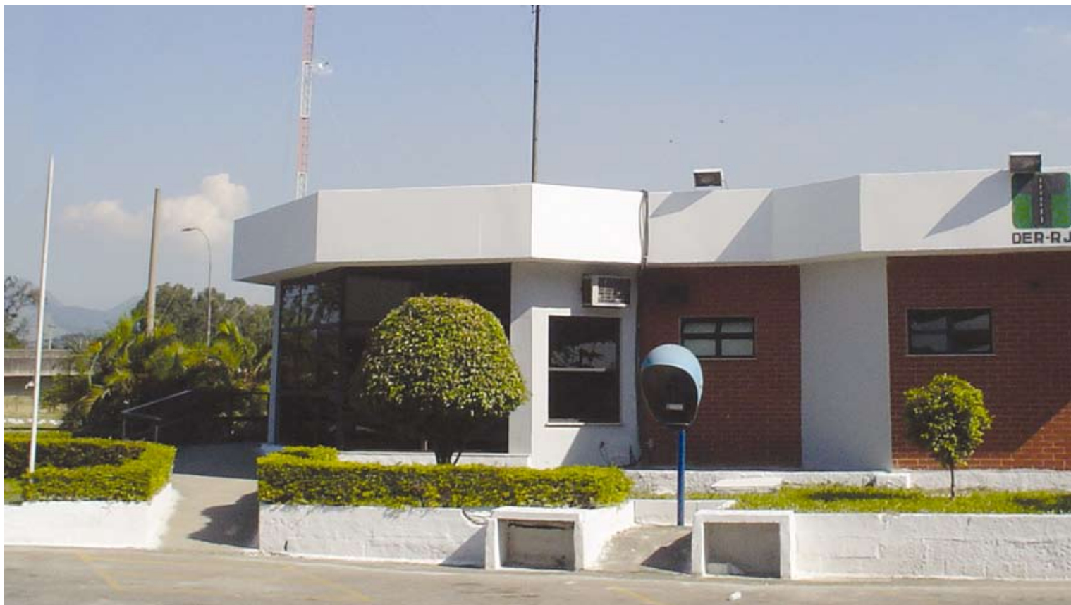
Sede do Centro de Controle de Operações (CCO), instalado na região do Trevo das Missões, próximo à rodovia Presidente Dutra, no Rio.
